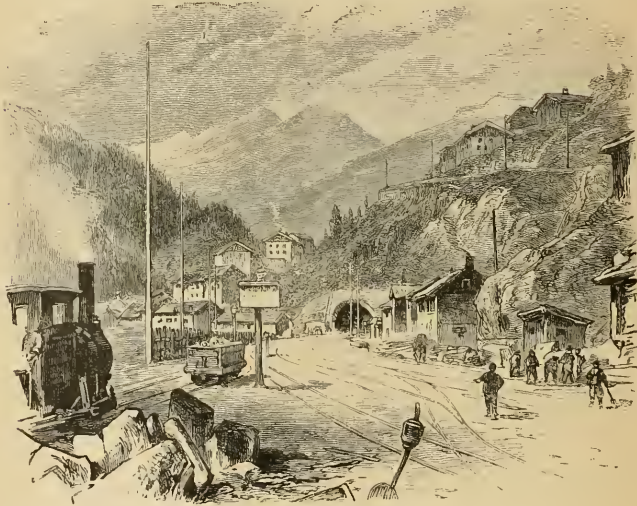
FIG. 132. — CHANTIER A LANGEN
